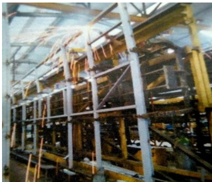
Pemasangan Rangka Kanan , Kiri Dan Rangka Atap
