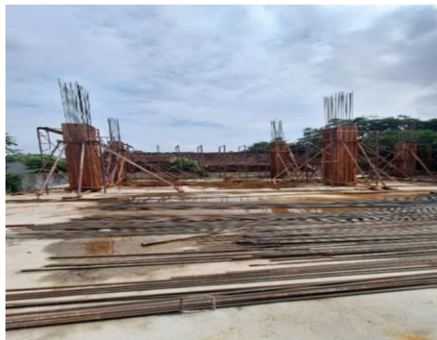
Gambar 2. Pembekistingan Kolom
