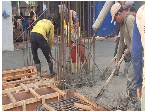
Gambar 3. Pengecoran Kolom
