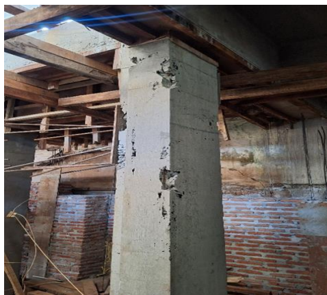
Gambar 6. Kolom Tidak Sempurna
