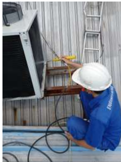
Gambar 3. Pencucian Kondensor
