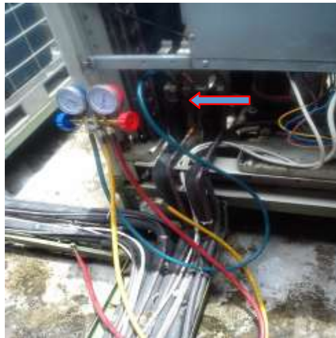
Gambar 2. Pengecekan tekanan Freon pada AC Split Duct
