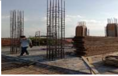
Gambar 3. Penulangan kolom
