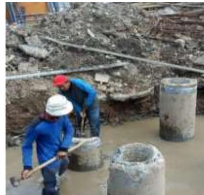
Gambar 6. Pekerjaan pemotongan pondasi bore pile
