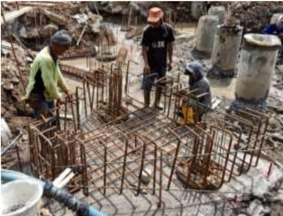
Gambar 9. Penulangan Pile cap
