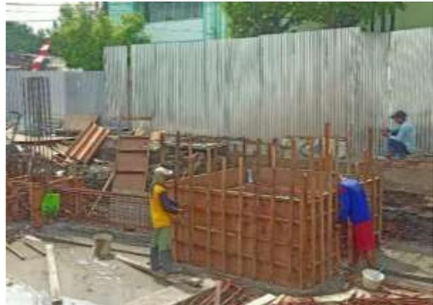
Gambar 10. Pemasangan bekisting Pile Cap
