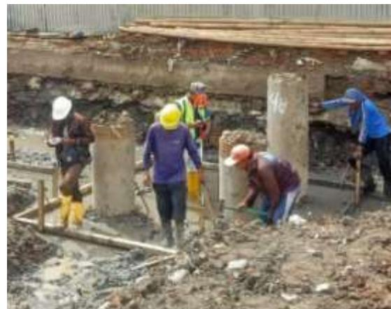
Gambar 8. Pembuatan lantai kerja
