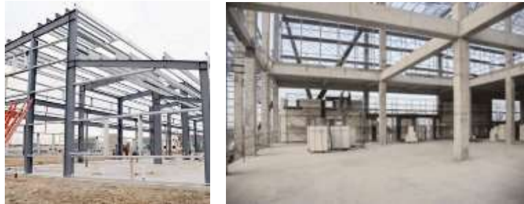
Gambar 18. Struktur Kolom Balok Beton Bertulang dan Baja
