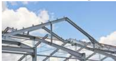
Gambar 19. Struktur Atap Baja WF
