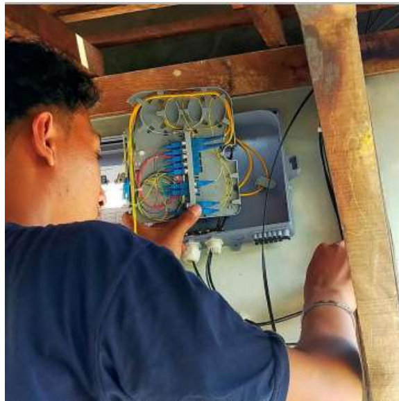
Gambar 3 Pemasangan ODC
