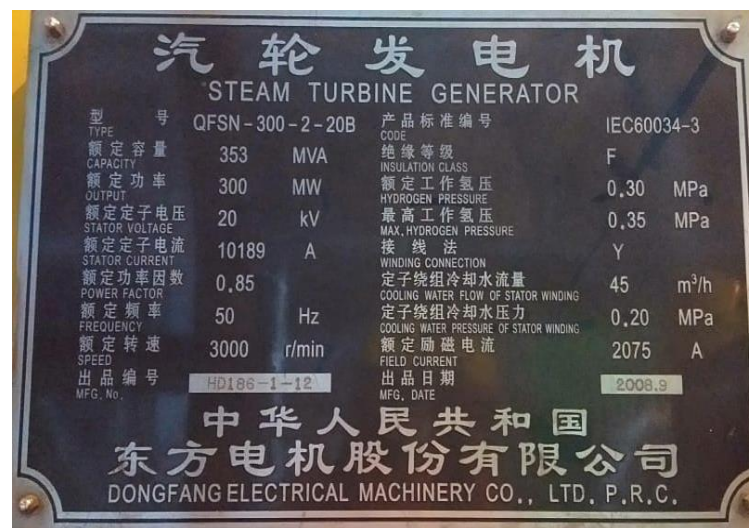
Gambar 1. Name Plat Generator PLTU Rembang
