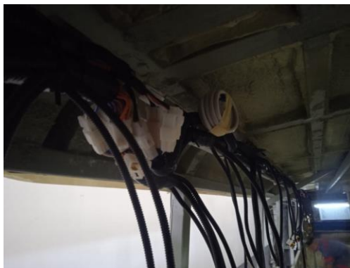
Gambar Hasil pemasangan kabel wiring
