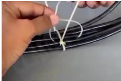
Gambar Pemasangan kabel dan ikat kabel ties
