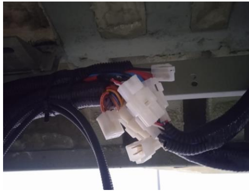
Gambar Pemasangan socket
