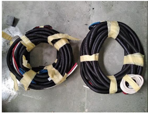
Gambar Pemilahan Kabel
