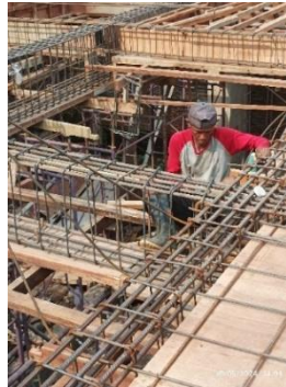
Gambar 5. Penulangan Balok
