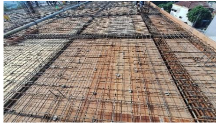
Gambar 6. Penulangan Plat Lantai
