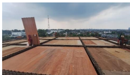
Gambar. 4 Bekisting Platantai
