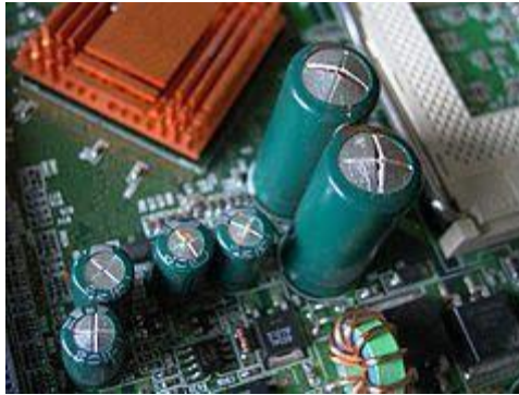
Gambar 8. Kapasitor yang pecah bagian atasnya
