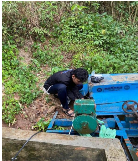
Gambar 18. Pemasangan Kabel dari Output Generator Menuju Input ELC
