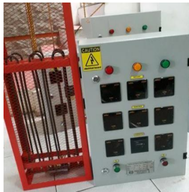
Gambar 23. Ballast Load Heater dan ELC Box
