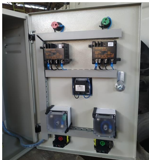
Gambar 19. Bagian Dalam Panel ELC
