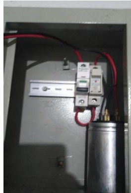
Gambar 3. Capacitor Bank yang terpasang Pada Panel kelistrikan
