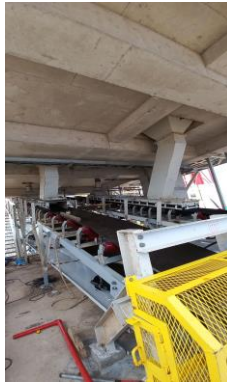
Gambar 4. Loading line Coal Handling System (sebelum dirancang Diverter Gate untuk BC 07)
