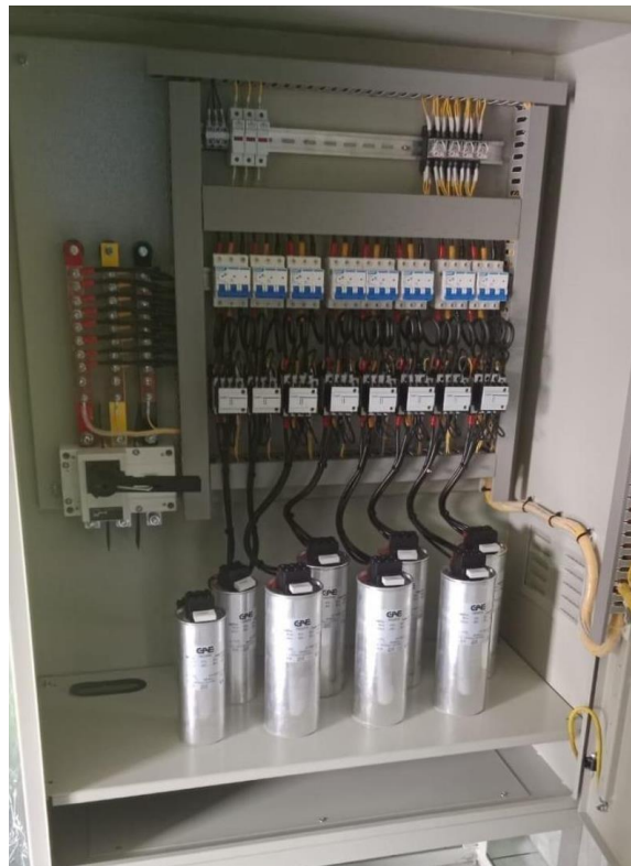
Gambar 2. Capacitor Bank Pada Panel Kelistrikan
