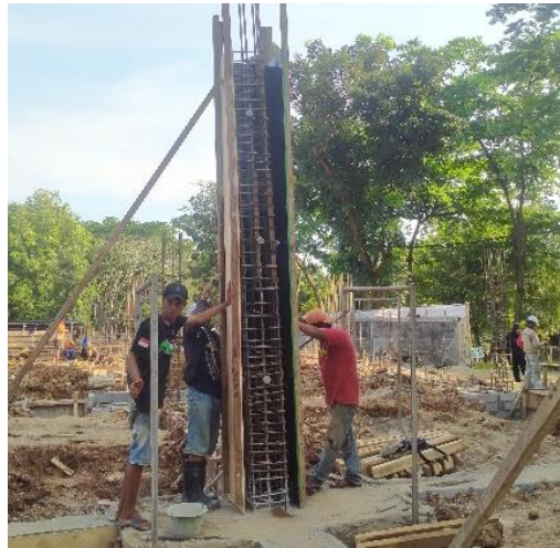
Gambar 1. 4 Pemasangan Bekisting Kolom
