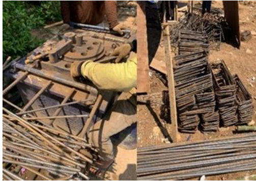
Gambar 1. 3 Penulangan Kolom
