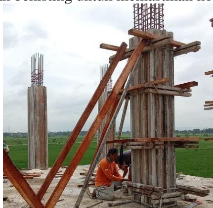
Gambar 4. Pemasangan Bekisting Kolom
