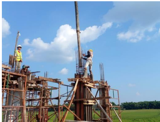
Gambar 5. Pengecoran Kolom
