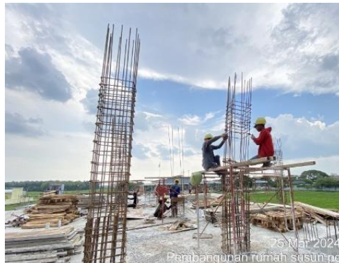
Gambar 3. Penulangan Kolom
