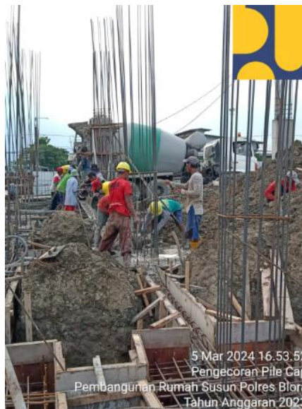
Gambar 13. Pengecoran Tie Beam dan Pile Cap
