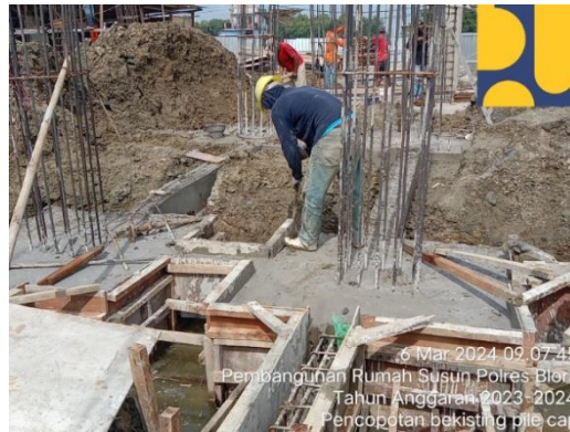
Gambar 14. Pengecoran Tie Beam dan Pile Cap
