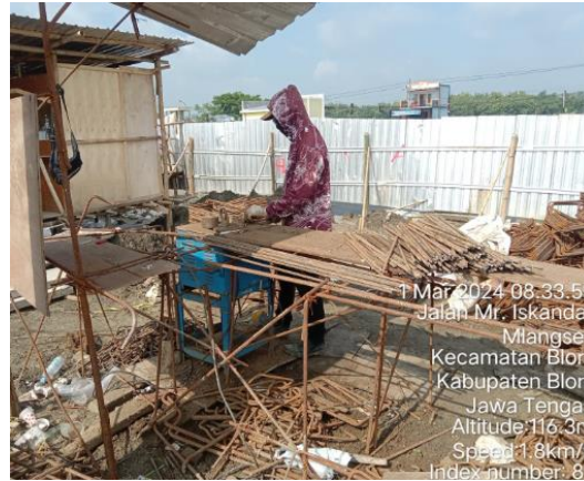
Gambar 7. Pekerjaan Penulangan Pile Cap
