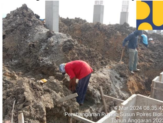
Gambar 10. Pekerjaan Lantai Kerja Tie Beam
