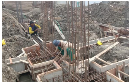
Gambar 11. Pekerjaan Penulangan Tie Beam
