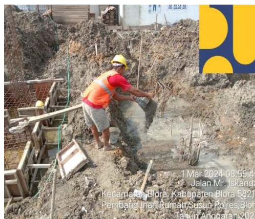
Gambar 6. Pekerjaan Uruga Pasir dan Lantai Kerja Pile Cap
