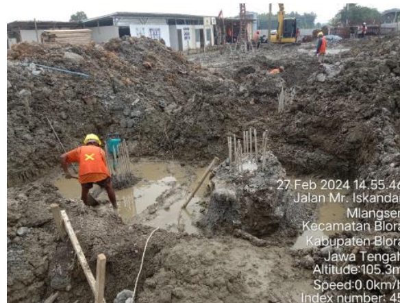
Gambar 5. Pemotongan Bore Pile
