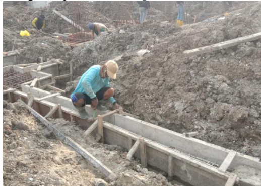
Gambar 12. Pekerjaan Penulangan Tie Beam
