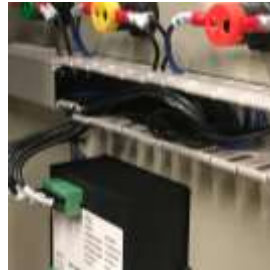
Gambar 2. Penataan Kabel dalam Duct
