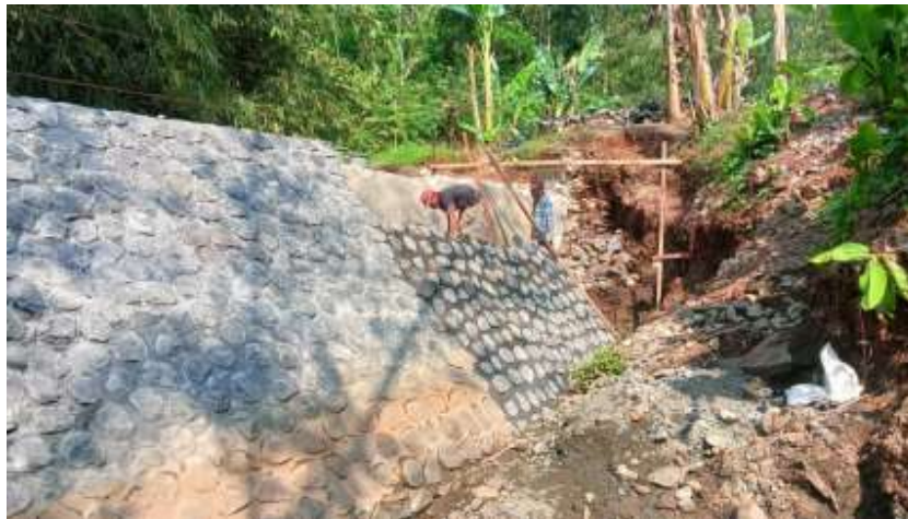
Gambar 9. Pemasangan Batu Kali pada Badan Bendung
