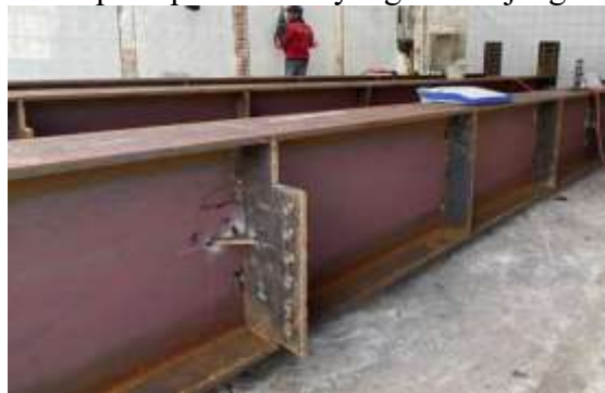
Gambar 4.4 Hasil Pengelasan Pelat Sambung (Sumber : Dokumentasi pribadi,2025)
