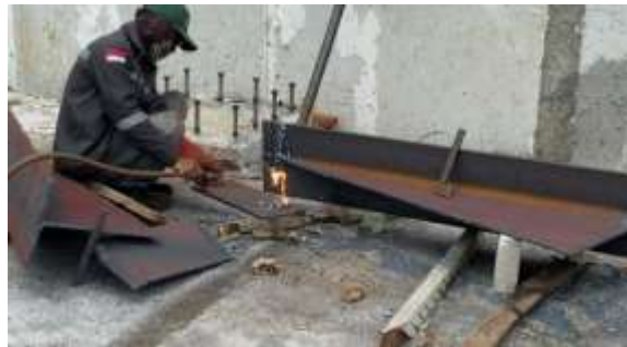
Gambar 4.3 Pekerjaan Pemotongan Voute (Sumber : Dokumentasi pribadi)
