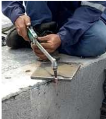
Gambar 4.1 Pekerjaan Pemotongan Stiffener (Sumber : Dokumentasi Pribadi,2025)
