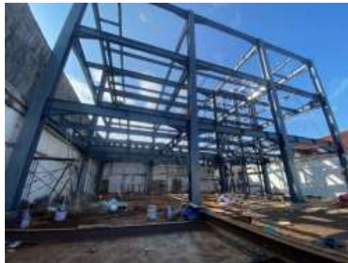
Gambar 4.6 Hasil Proses Erection Zona 1 (Sumber : Dokumentasi pribadi)
