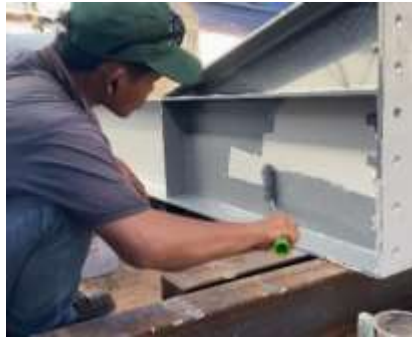
Gambar 4.5 Proses Pengecatan Finishing (Sumber : Dokumentasi pribadi,2025)
