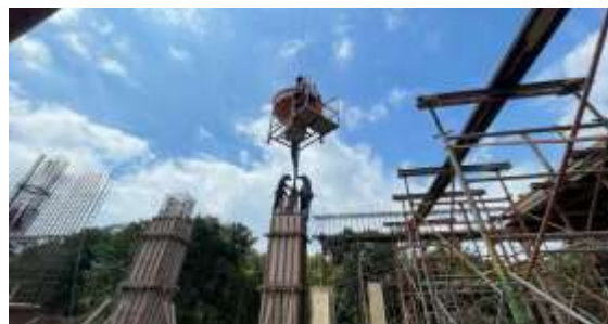
Gambar 2. Pengecoran Kolom di Lapangan (Sumber: Dokumentasi Penulis, 2025)
