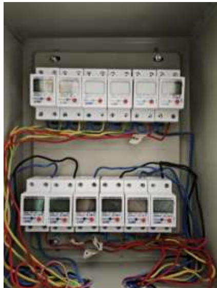
Gambar 4. Gambar Panel kWh Meter Digital Sebagai Pemantau Konsumsi Energi 12 Kamar Hotel
