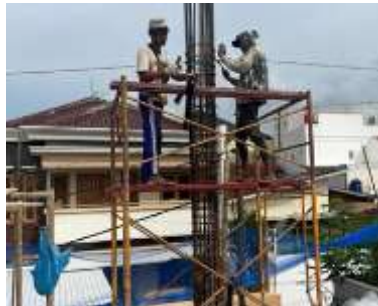
Gambar 3. Pembesian Kolom
