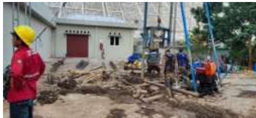
Gambar 1. Pengeboran Bore Pile
