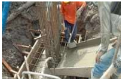
Gambar 4. Pengecoran pile cap
