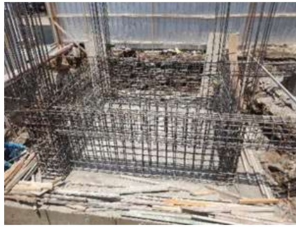
Gambar 3. Penulangan pile cap
