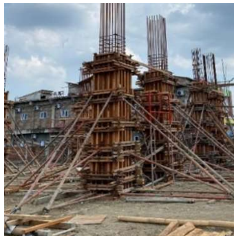
Gambar 8. Bekisting Kolom
