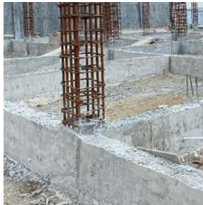
Gambar 6. Pembongkaran Bekisting
