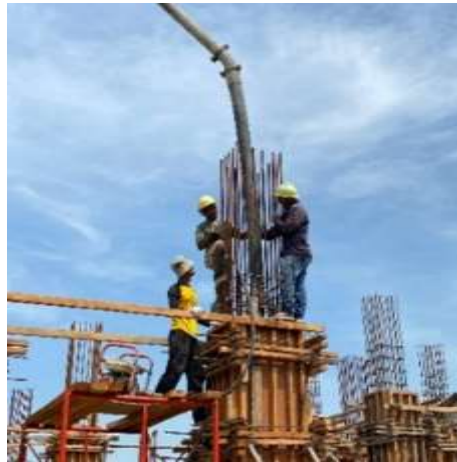
Gambar 9. Pengecoran
