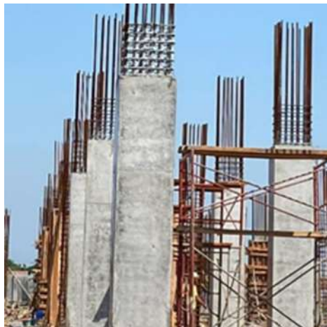
Gambar 10. Pembongkaran Bekisting Kolom
