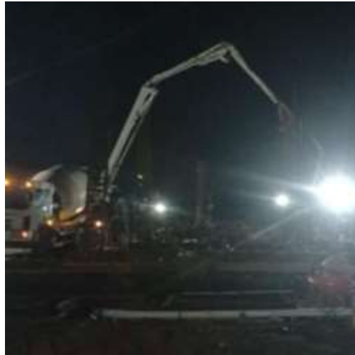
Gambar 5. Pengecoran Kolom
