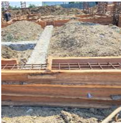
Gambar 4. Pemasangan Bekisting
