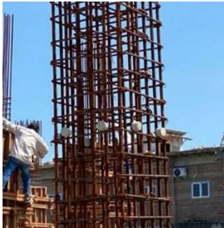
Gambar 7. Pembesian Kolom
