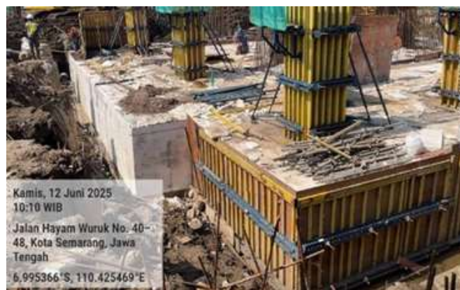
Gambar 3 Pembongkaran Bekisting (Sumber : Dokumentasi Penulis, 2025)
