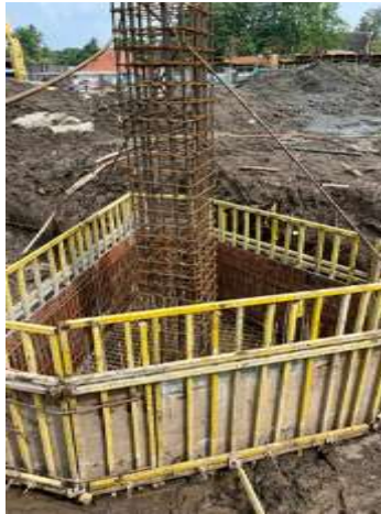
Gambar 2 Pemasangan Bekisting P1A (Sumber : Dokumentasi Penulis, 2025)
