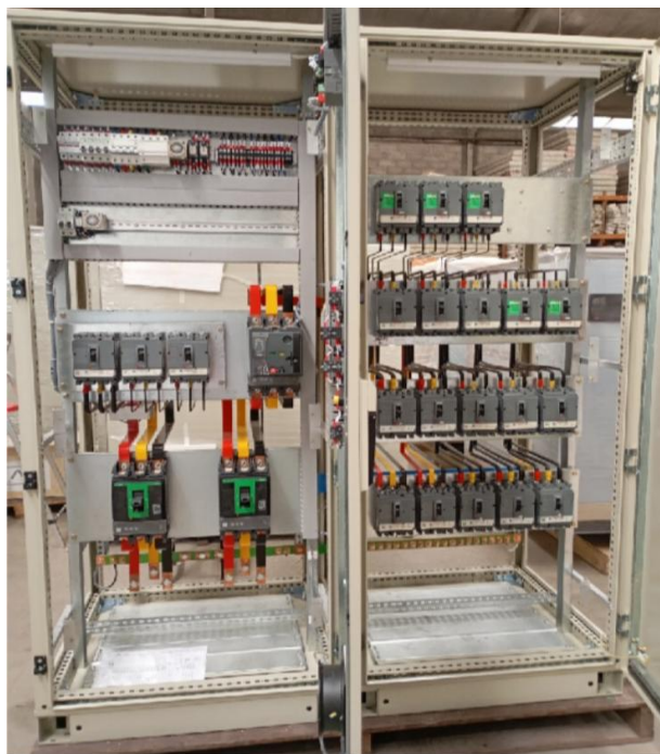
Gambar 3. Tampilan Internal Panel SDP Siap Uji
