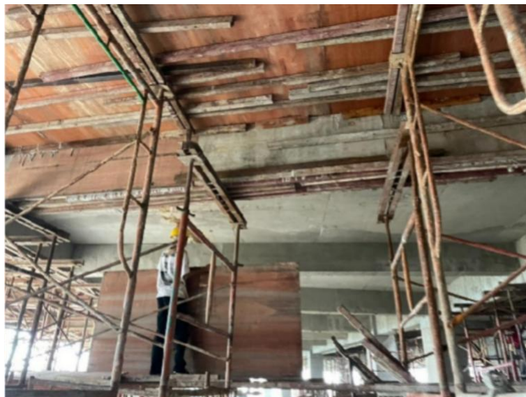
Gambar 15 Pelepasan Bekisting Balok
