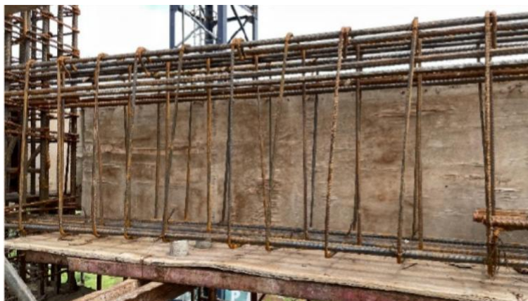
Gambar 6 Penulangan Balok
