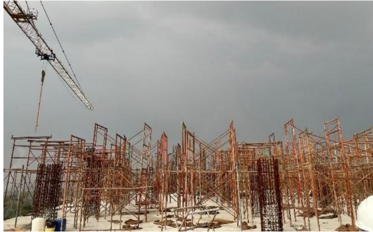
Gambar 2 Pemasangan Scaffolding
