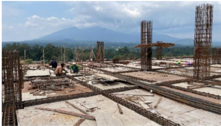
Gambar 5 Pekerjaan Penulangan Balok
