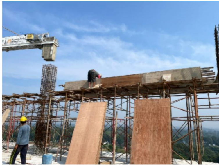
Gambar 11 Pemasangan Bekisting
