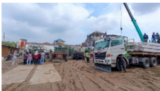
Gambar 4. 3 Gambar Mobilisasi Mini Pile pada Pekerjaan Mini Pile
