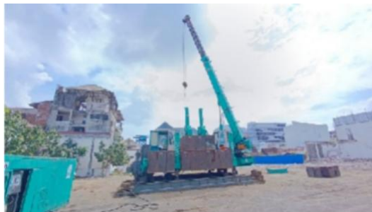
Gambar 4. 2 Gambar Mobilisasi HSPD pada Pekerjaan Mini Pile
