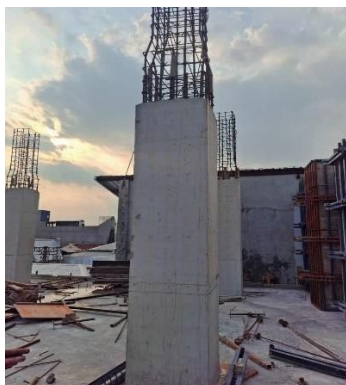
Gambar 1.4 Pembongkaran bekisting kolom (Sumber: Dokumentasi Penulis, 2025)
