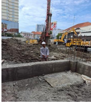
Gambar 1.2 Pembongkaran bekisting Sloof (Sumber: Dokumentasi Penulis, 2025)
