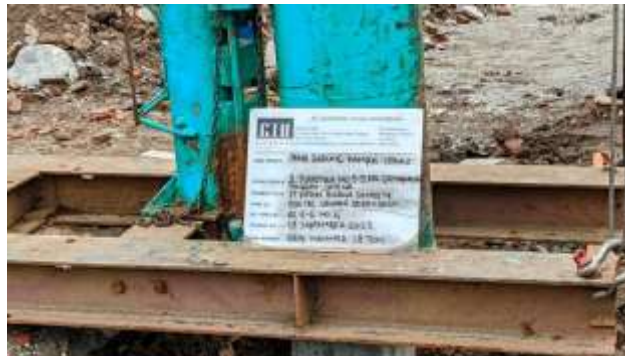
Gambar 48. PDA Test Pada As E-6 No. 4
