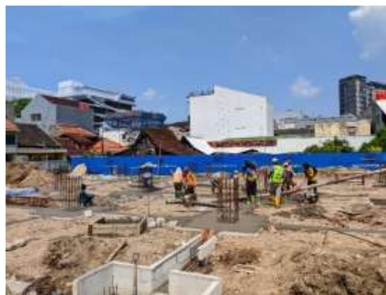
Gambar 58. Pengecoran Pile Cap dan Tie Beam (Sumber: Dokumentasi Pribadi).
