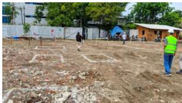
Gambar 46. Penentuan Posisi Pile Cap
