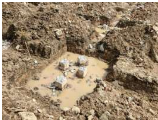
Gambar 50. Pekerjaan Pembobokkan Pancang (Sumber: Dokumentasi Pribadi).
