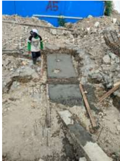
Gambar 51. Pekerjaan Lantai Kerja (Sumber: Dokumentasi Pribadi).
