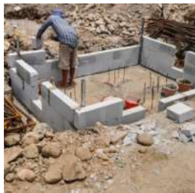
Gambar 52. Pemasangan Bekisting (Sumber: Dokumentasi Pribadi).
