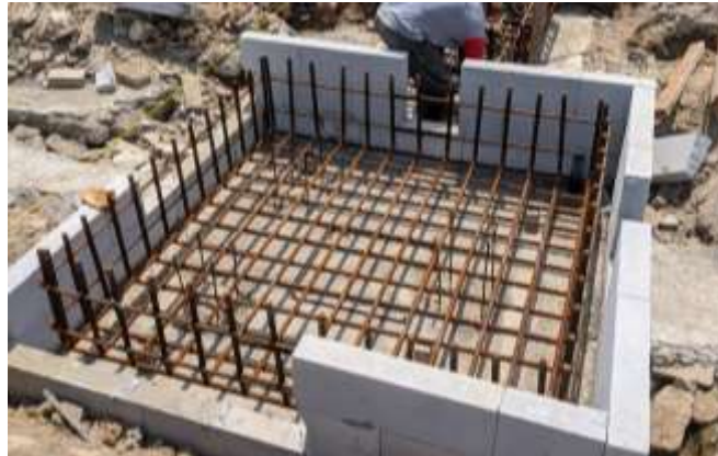
Gambar 57. Pemasangan Pembesian (Sumber: Dokumentasi Pribadi).
