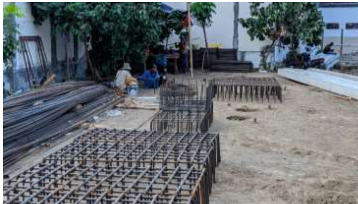
Gambar 55. Fabrikasi Pembesian (Sumber: Dokumentasi Pribadi).
