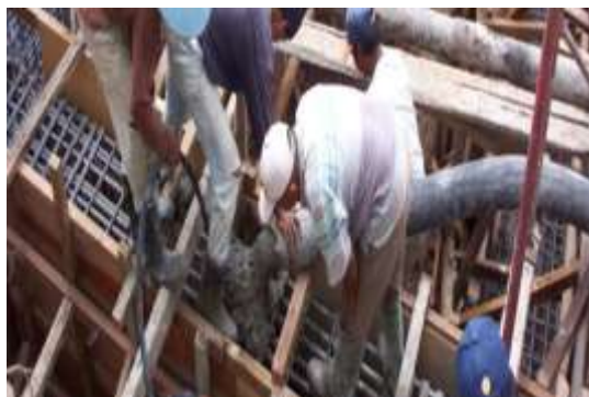
Gambar 7. Pelaksanaan Pengecoran Tie Beam.
