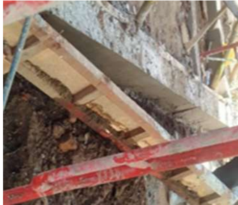
Gambar 8. Pekerjaan Pembongkaran Bekisting Tie Beam.
