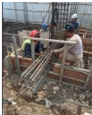
Gambar 4 Pemasangan Tulangan Tie Beam .
