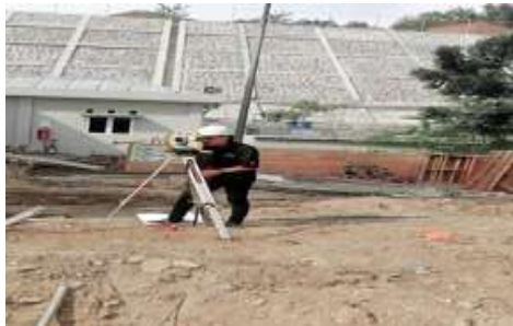
Gambar 2 Pengukuran Tie Beam oleh Surveyor.
