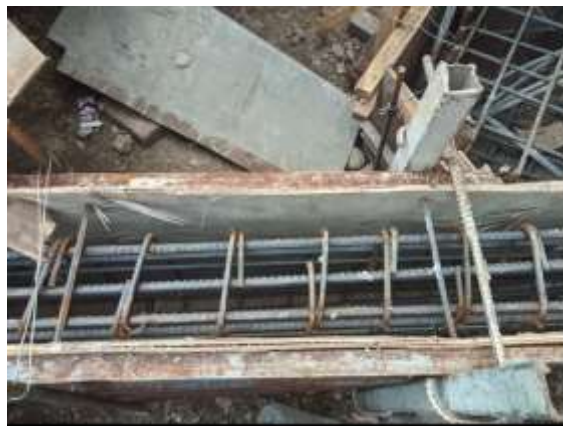
Gambar 5 Pemasangan Bekisting .
