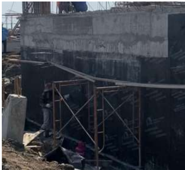
Gambar 3. Pemasangan Membran Bakar ( Silver Roll ).
