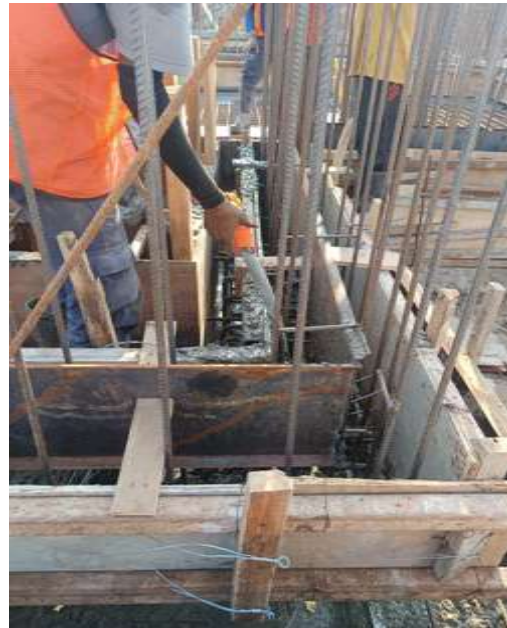
Gambar 2. Proses Pemadatan Cor dengan Vibrator.
