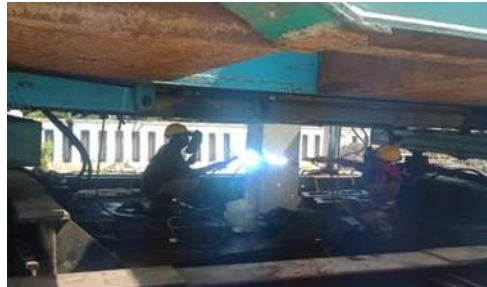
Gamabr 5. Penyambungan Tiang Pancang dengan Las.
