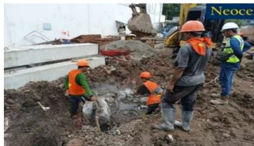
Gambar 6. Pemotongan Sisa Tiang Pancang.
