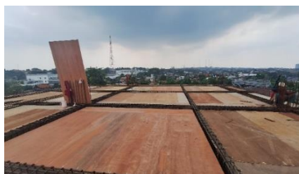
Gambar. 4 Bekisting Platantai
